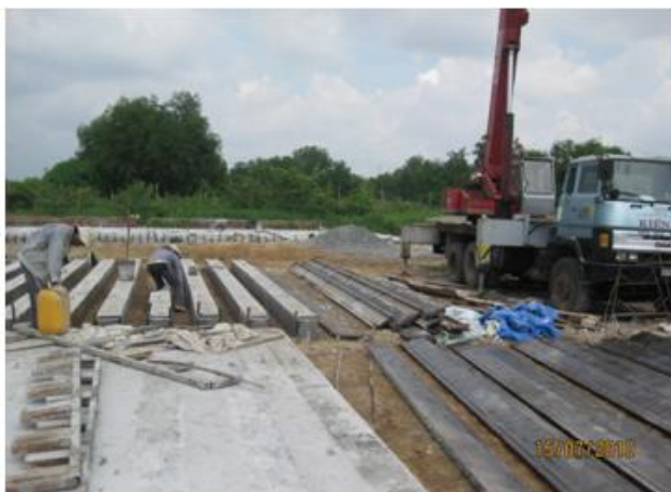
Lắp đặt cốp pha cọc tại xưởng
