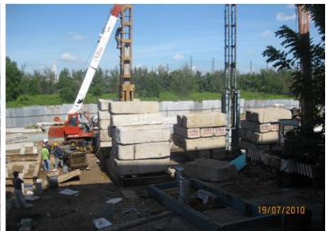
Thi công ép cọc bằng 02 dàn ép tại công trường
